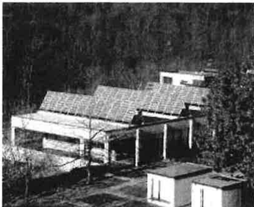
Abbildung 6 – Netzverbundanlagen: TISO 1982, 10kWp
