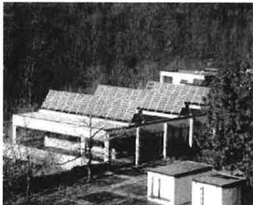
Abbildung 6 – Netzverbundanlagen: TISO 1982, 10kWp
