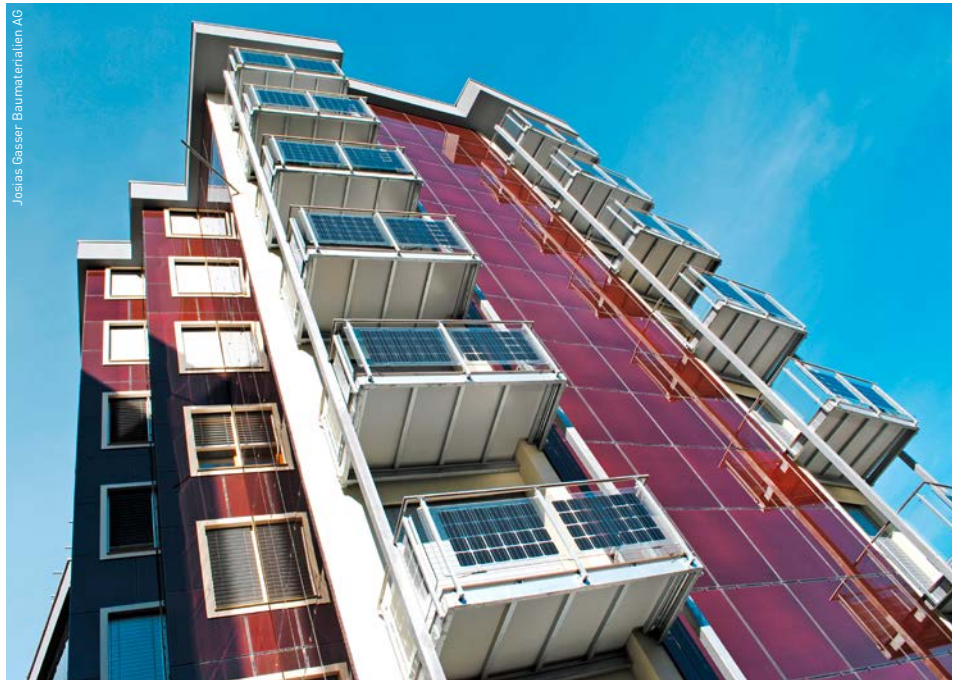
Die Photovoltaik spielt beim Plusenergie-Konzept eine vorrangige Rolle. Das Bild zeigt ein saniertes Hochhaus in Chiasso.
